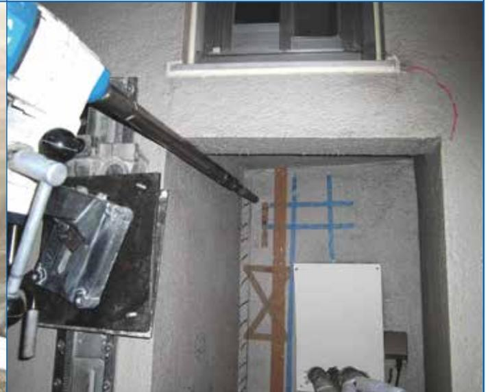
水平スリットの施工
