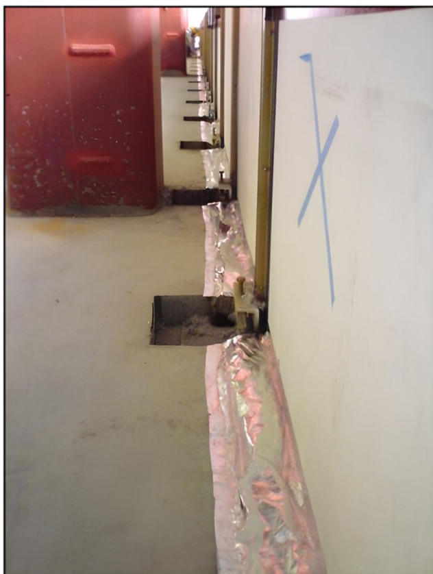
【ソーカンパックALタイプ 施工例】 ※ファスナー部分
