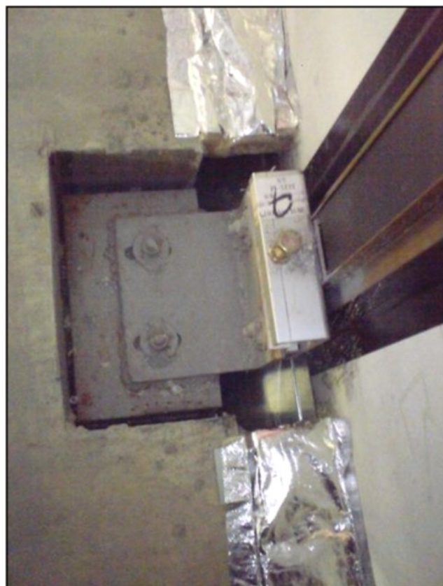
【ソーカンパックALタイプ 施工例】 ※ファスナー部分
