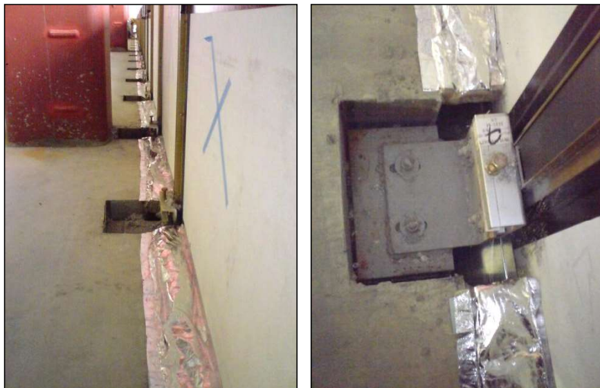
【ソーカンパックALタイプ 施工例】 ※ファスナー部分
