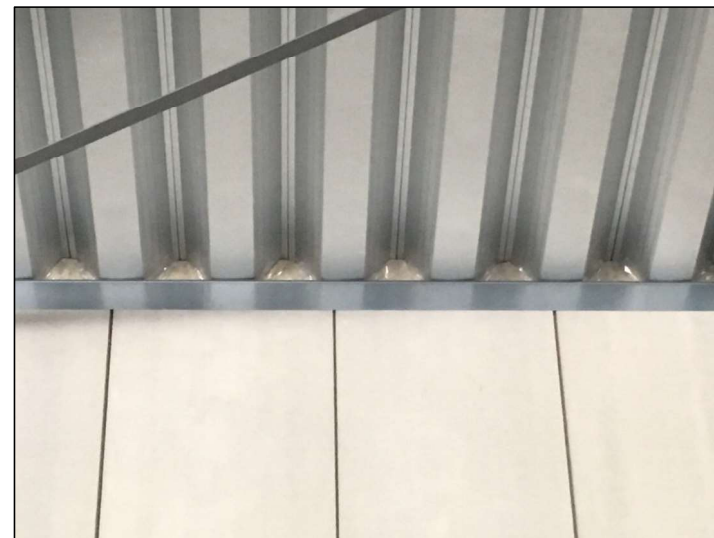
【ラクダパック 施工例】 ※折板屋根
