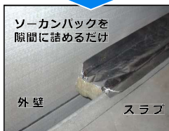
施工されたソーカンパック
